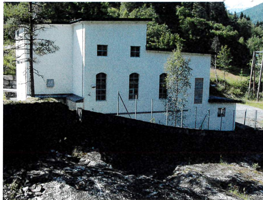
Kolfossen kraftverk, foto: Wikipedia
