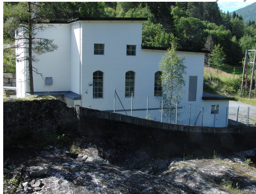
Kolfossen kraftverk, foto: Wikipedia
