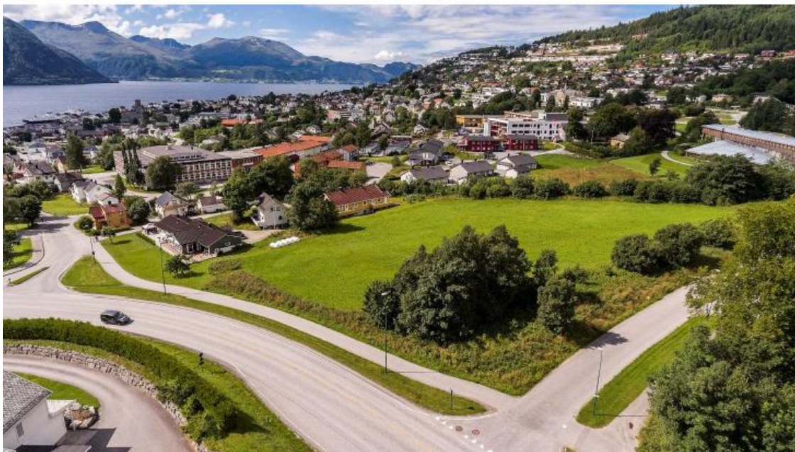
Dronefoto frå aust mot vest med krysset E39/Joplassevegen i nedre biletkant. I bakgrunnen frå venstre mot høgre: Volda ungdomsskule, Øyra barneskule og Berte Kanuttebygget (HiVolda).
