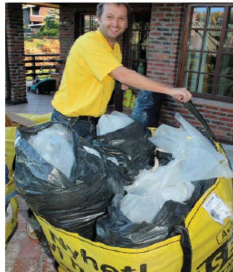
1 sekk er et nytt system for kildesortering av avfall på mindre byggeplasser.
