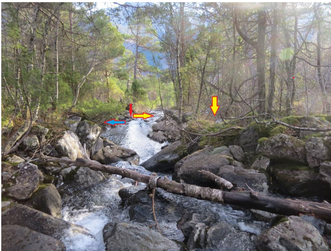
Figur 17 Bekkefareet med utløp til sidebekk - rød pil figur 14. Liggende gul pil viser hovedløp – stående gul pil viser avlastningsløp som kommer sammen med hovedløp lenger ned i terrenget. Store blokker stabilisere og definere elveløpet.
