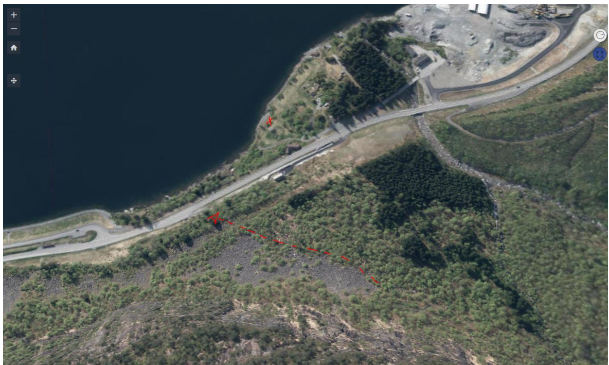
Figur 15 Oversiktsbilde viser utstrekning av tallus på nedsiden av løsneområdet i siden øst for annekset. Annekset vurderes til å være signifikant utenfor utløpsområdet. Løsneområdet består av en steil side, definert i N-S orientert foliasjonsplan med sterk vestlig dip.
