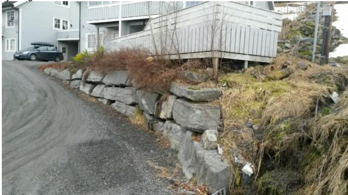
Foto eksisterande situasjon- Engesetgeila 5.
