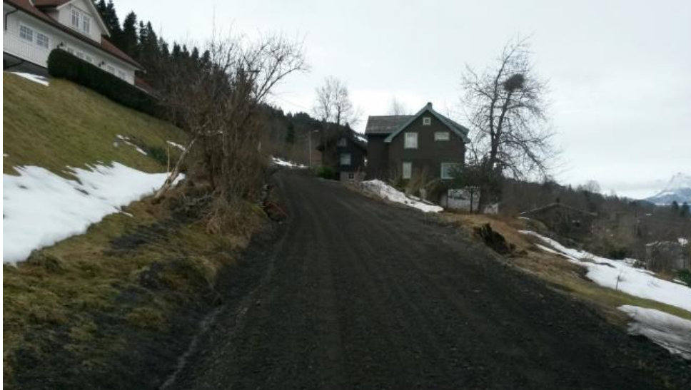
Foto dagens situasjon 18/35
