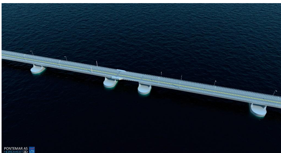
Figur 6-3 Illustrasjon av lågbru med stengd skipssluse (LMG Marin AS)
