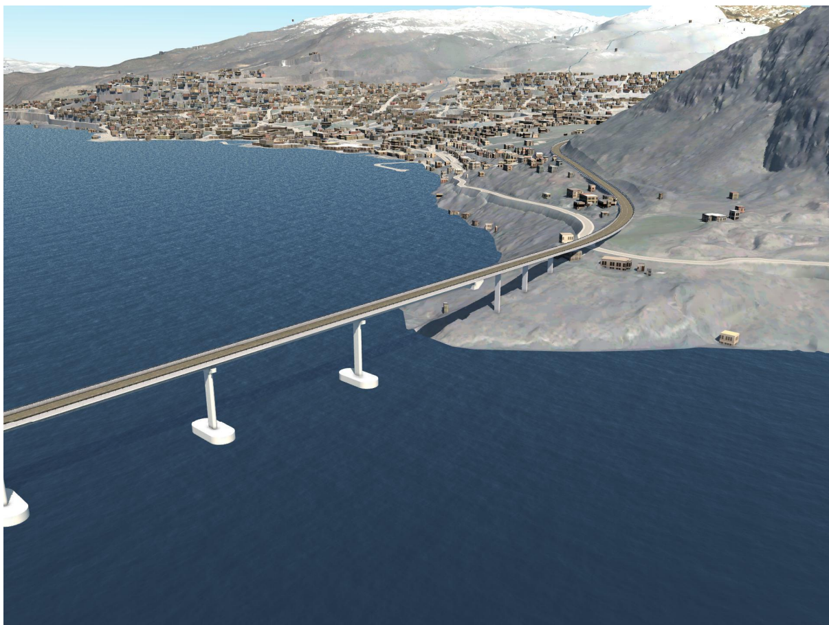
Figur 5-6 Alternativ 2B - flytebru med fast seglingsløp ved Andaneset og veg i dagen til Rotset
