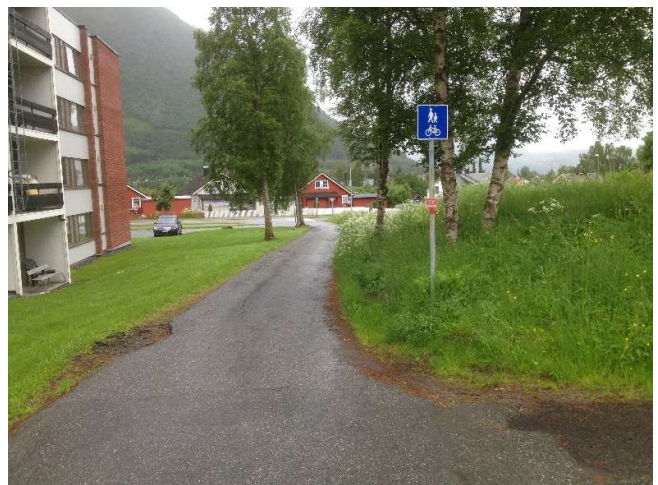
Figur 12 Frå Nygardsvegen nedover Grønbakken mot Fv45
