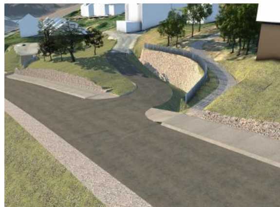
Foto eksisterende situasjon 18/40
