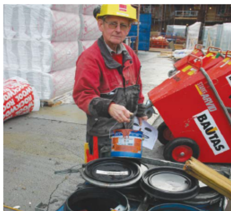
Egen beholder for farlig avfall
