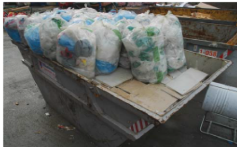
Kombinasjon av en tung fraksjon (gips) og en lett fraksjon (plast) an en container.
