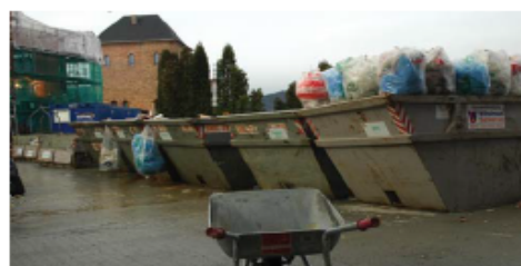
Skrapers containere samlet på et sentralt sted på byggeplassen.
