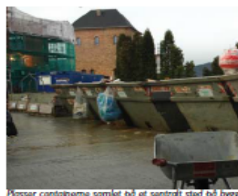
Plaster containere samlet på et sentralt sted på bygge-
