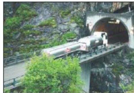
Vognar på veg inn i den låge og smale Ospeltunnelen på riksveg 15 på Strynefjellet. Ei bransje som også manglar vifter.
