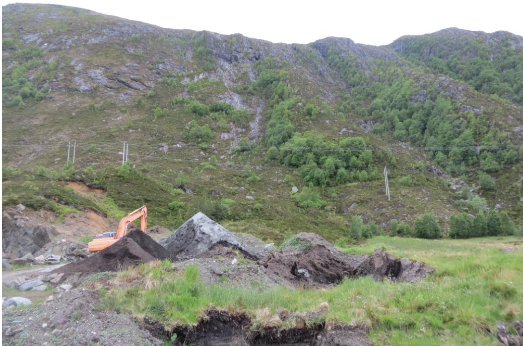
Figur 23 I utkanten av planarealet – på forhøyninger - ligger tynt lag siltig sand på fjellet.
