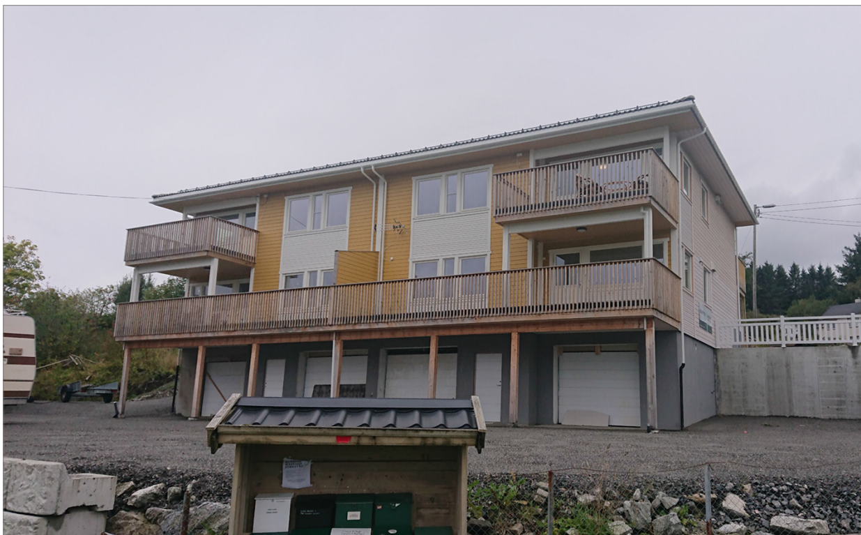
Bilde frå bygg på gbnr 29/32.
