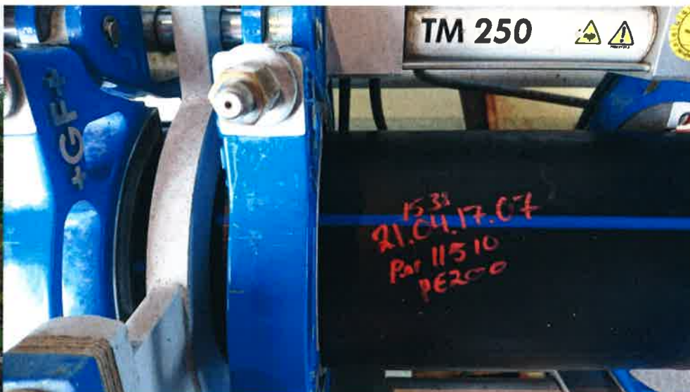
Sveising av PE-rør
