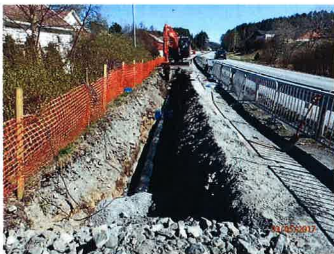
Borgarhaugvegen, Ny leidning i gangvegen
