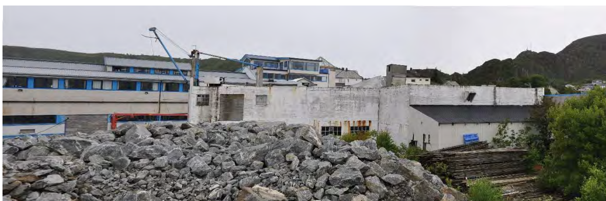
Figur 3-5 Mot bygningar kring hamna
