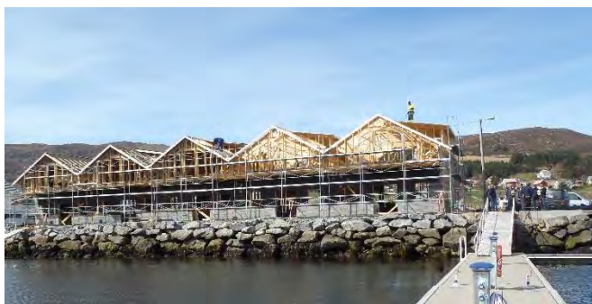
Bebyggelse på bakareal almenningsskai
