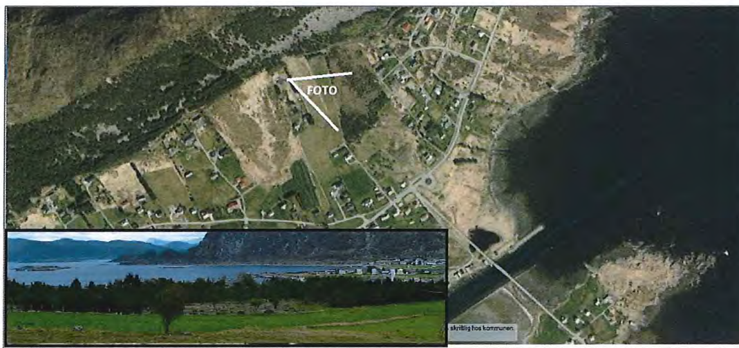
Flyfoto og oversiktsbilde fra nordvest
