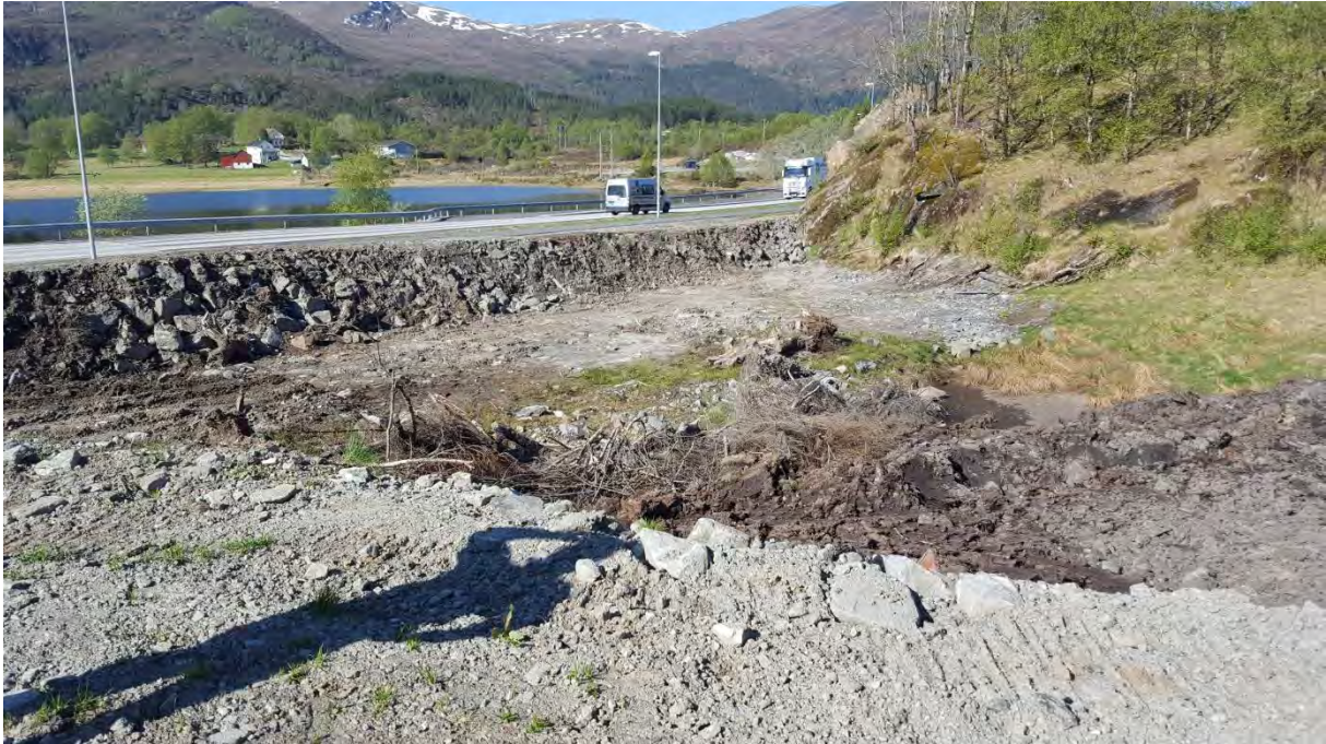
Bilete 3: Området for deponering av jordmasser
