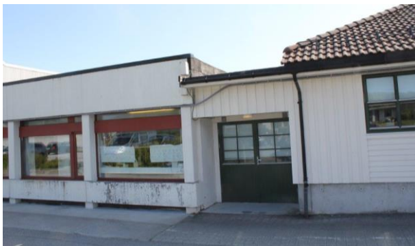
Bilde 7 viser seksjoneringsvegg mellom omsorgssenteret og helsesenteret i fasade mot nord.
