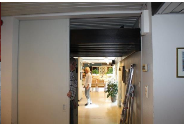
Bilde 6 viser port i seksjoneringsvegg
