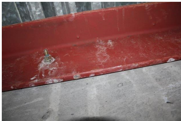
Bilde 5 viser utførelse av seksjoneringsvegg mot tak.
