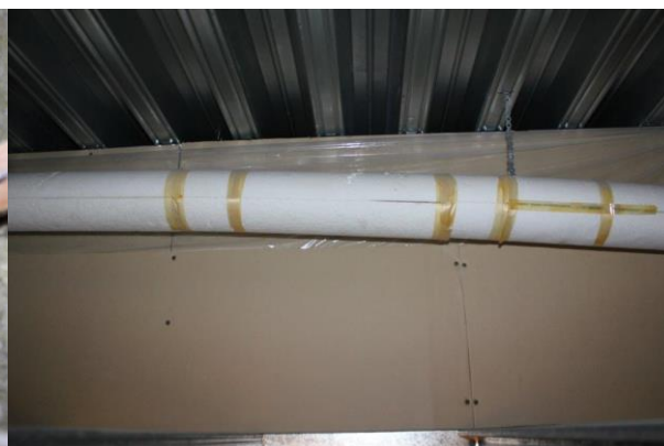
Bilde 20 viser utførelse av brannskille over himling i teknisk gang mellom lagerrom og korridor.
