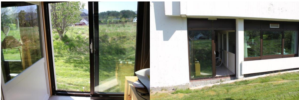
Bilde 35 viser rømningsdør til det fri i enden av rømningskorridor. Legg merke til terskel på skyvedør og låssystem.
