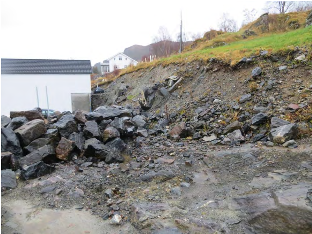
Figur 2 Skjæringen sett mot øst
