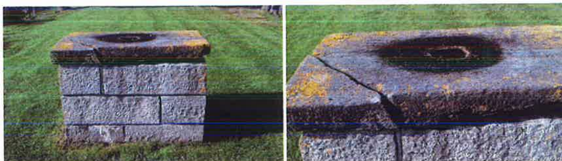
Nytt alter i Mariakyrkjetomta med helle i frå marmorkyrkja. Denne har ein sprekk. . Mot V
