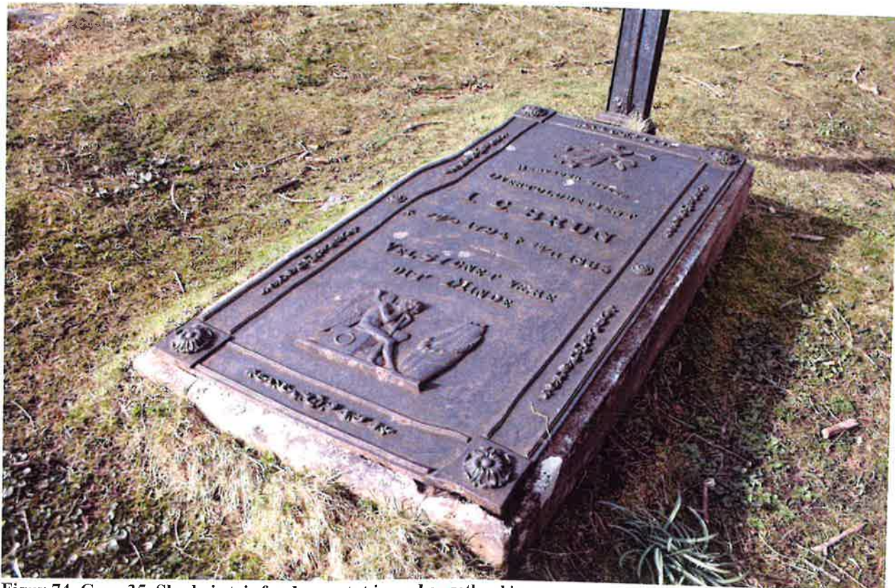
Figur 74. Grav 35. Skade i steinfundamentet i nordaustleg hjørne.
