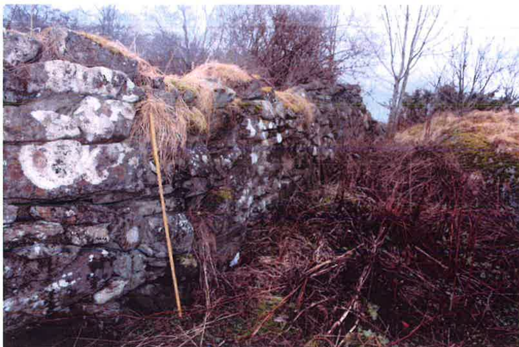
Figur 16. Bilete viser mykje vegetasjon, og ein noko utpressa kyrkjegardsmur.
