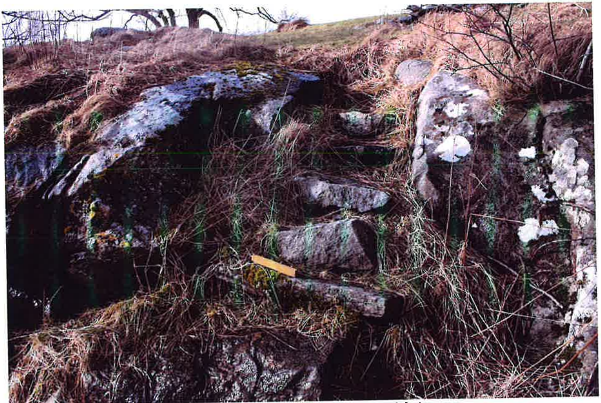
Figur 111. Trapp bygd av naturstein dannar det fyrste partiet av stien frå sjøen.
