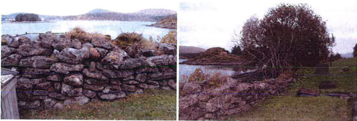
T.v. Utrasing rett aust av nordporten. Grastorv i topp. Hamna nedanfor. Kjekt å sjå fjorden! Flåvørleia. T.h. Same stad meir mot A. Muren vert lågare. Nokre eldre gravminne. Turrre bortanfor kan dette kva tid som helst.
