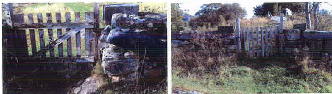
Vestporten t.v. innanfrå og ut mot V, t.h. utanfrå og inn mot A. Tydeleg bygningsstein.
