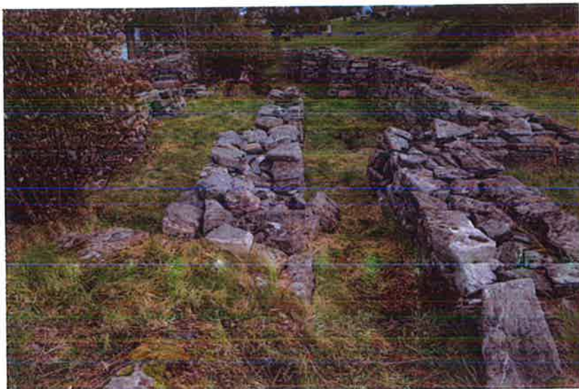
Behov for litt stabilisering også av indre steinar.
