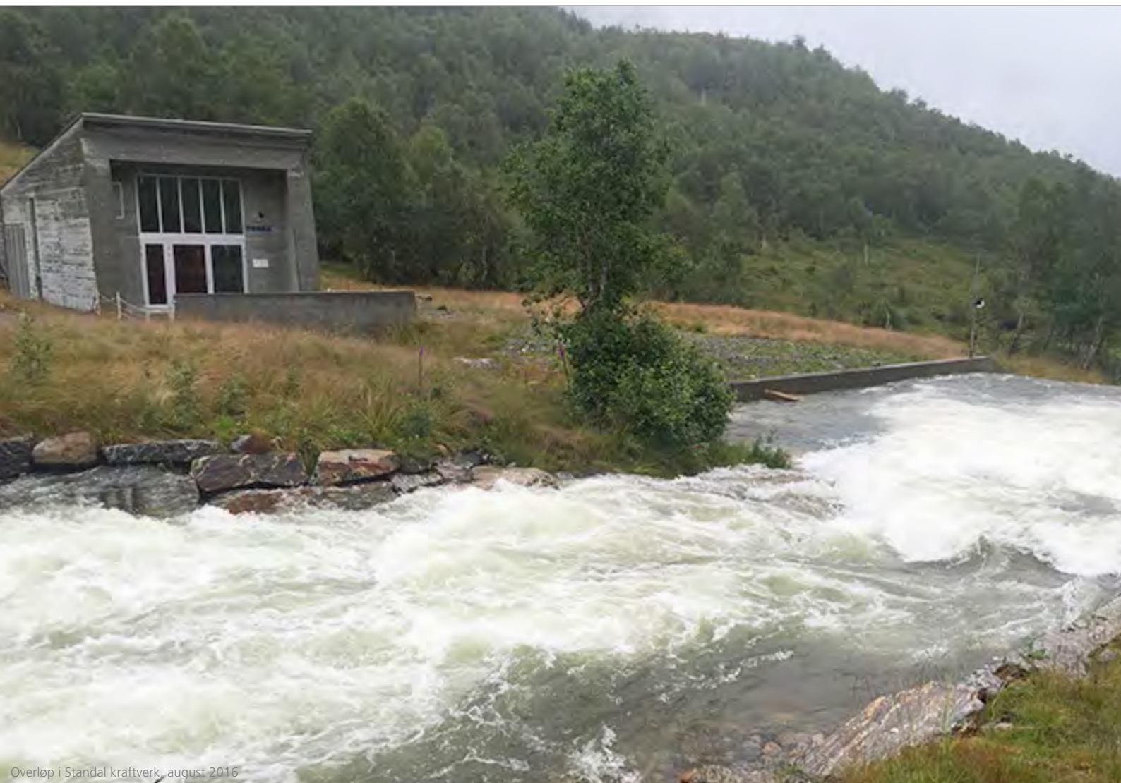
Overløp i Standal kraftverk, august 2016
