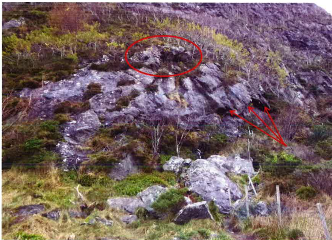
Figur 13: Bildet viser parti 9. Røde piler viser blokker som bør boltesikres. Innenfor rød sirkel bør vegetasjon renskes og blokker renkes eller boltes fast.
