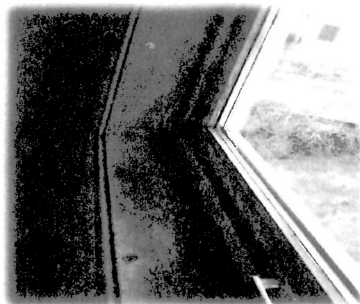
Bilde 19: Svertesopp i vindaugskarm
