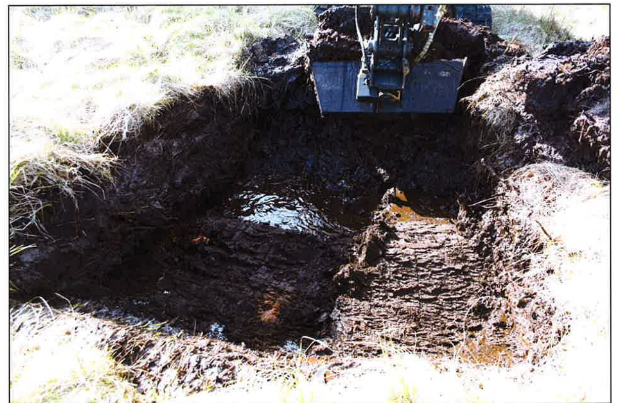
Figur 14 (under). Situasjonsbilde fra undersøkelsen. Prøvesticket (MPS#2) fylles raskt med vann. Tatt mot SØ. Foto: Jo Sindre P. Eidshaug
