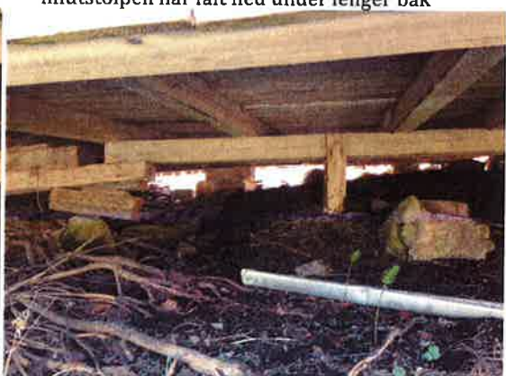
Midtstolpane under golvet har delvis velta og heile uthuset/løda vagger når vi går inne.
