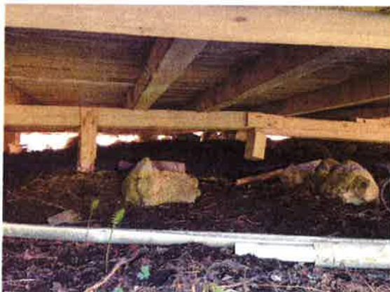
Midtstolpane under golvet har delvis velta og heile uthuset/løda vagger når vi går inne.
